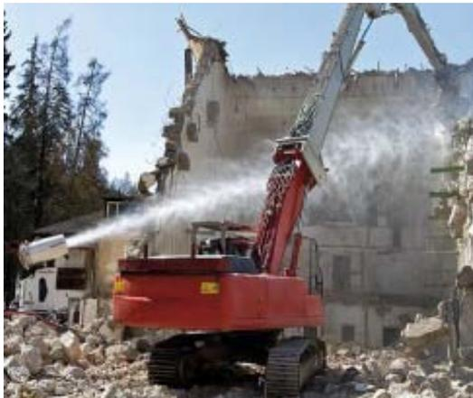
*Generatori di aerosol ventilato in un cantiere edile in fase di demolizione*
