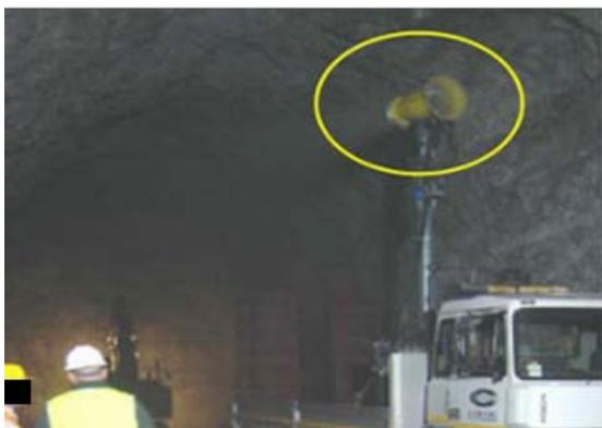
*Esempio di applicazione di aerosol ventilato in galleria mineraria*
